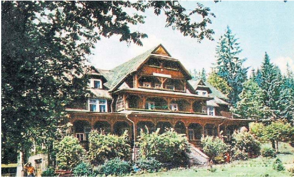
Zabytkowy, charakterystyczny, drewniany DW Pod Baranią zostanie tylko odnowiony - zachowa swój charakter, renowacja odbywa się pod okiem konserwatora zabytków
