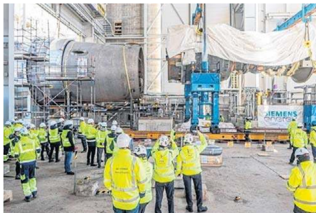
W Rybniku powoli dobiega końca budowa nowej elektrowni na gaz. Kolejny blok będzie wznoszony
