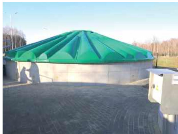
Inwestycja polegała na rozbudowie mechaniczno-biologicznej oczyszczalni ścieków
