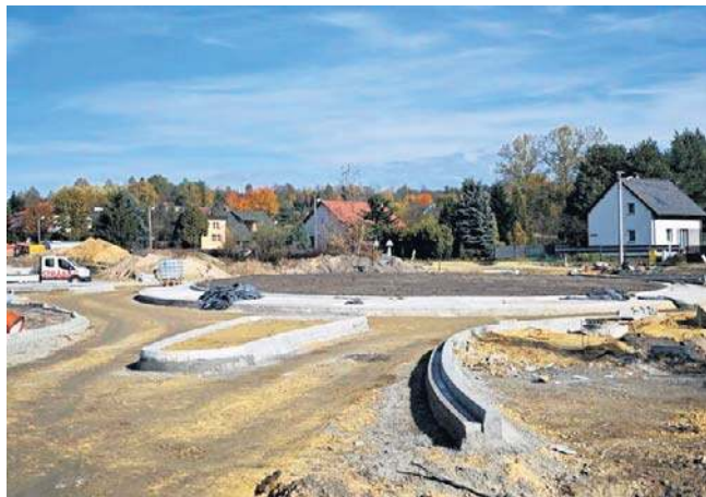
Obecnie trwają roboty przy budowie ronda – ostatnim kluczowym elemencie inwestycji
