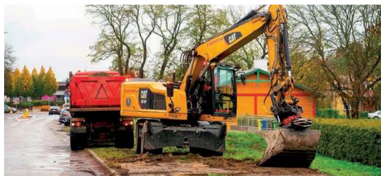
Na ulicę Fabryczną wjechały już koparki
