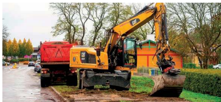
Na ulicę Fabryczną wjechały już koparki
