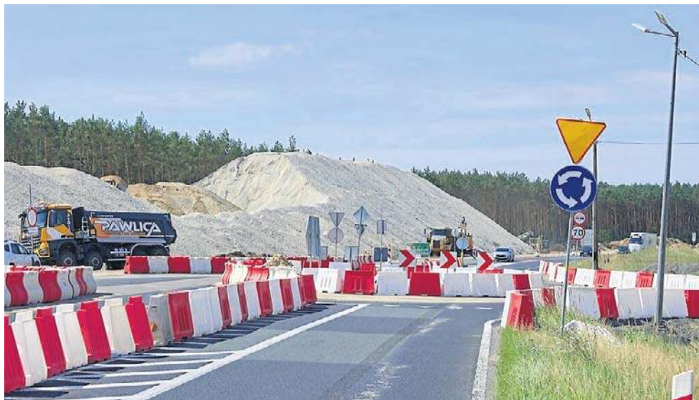
Roboty na budowie trasy ekspresowej S10 trwają między innymi na wysokości Glinek
