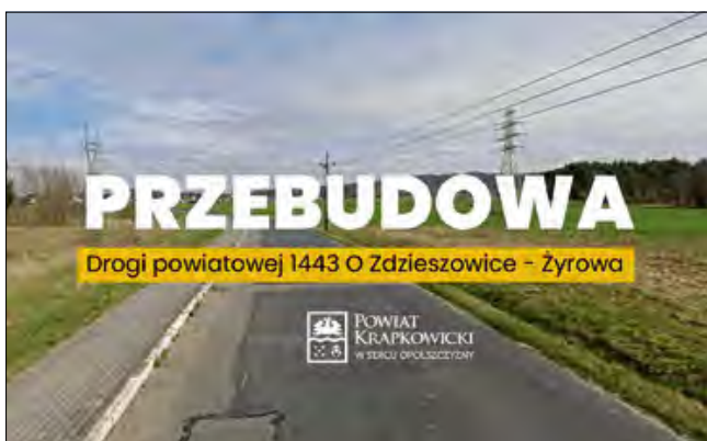
Dzięki pozyskanym środkom trasa na odcinku Zdzieszowice-Żyrowa zyska nową jakość.
