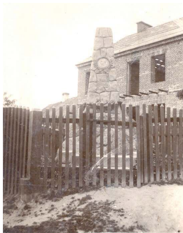
Budynek Urzędu Gminy w Biszczy, w budowie
