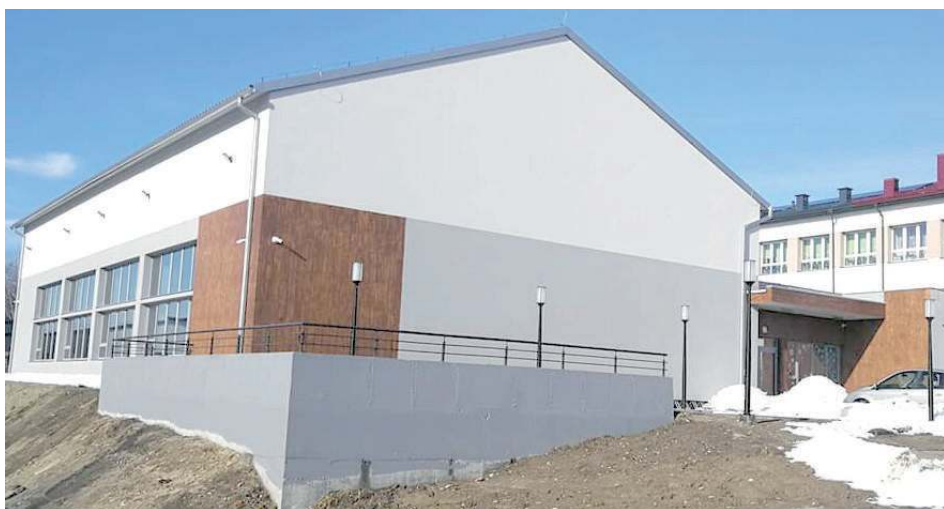
Sala gimnastyczna w Korchowie powstała na potrzeby realizacji zajęć wychowania fizycznego dla uczniów Szkoły Podstawowej w Korchowie Pierwszym oraz dla lokalnych stowarzyszeń sportowych i lokalnej społeczności w celu organizacji treningów, zajęć sportowych, turniejów oraz współzawodnictwa sportowego - czytamy na stronie Gminy Księżpol
