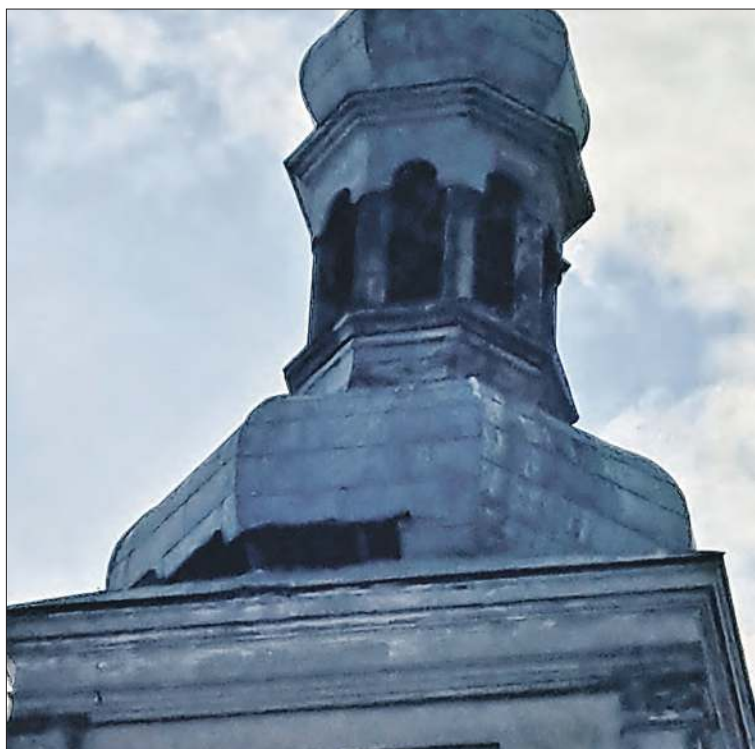
Z wieży znikają kolejne fragmenty blachy
