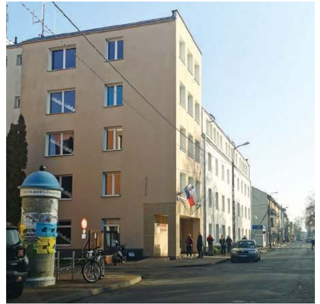
W kwietniu br. może rozpocząć się remont w budynku Urzędu Miasta
