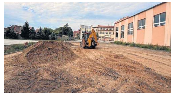
Przy Szkole Podstawowej nr 2 w Nowym Tomyślu powstaje nowoczesny kompleks sportowy, który będzie służył uczniom
