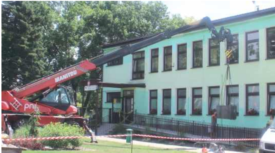
W czerwcu trwał remont w budynku bialskiego Powiatowego Urzędu Pracy
