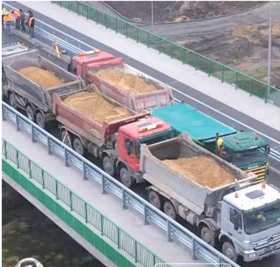
Próba obciążeniowa nowego mostu na Krznie
