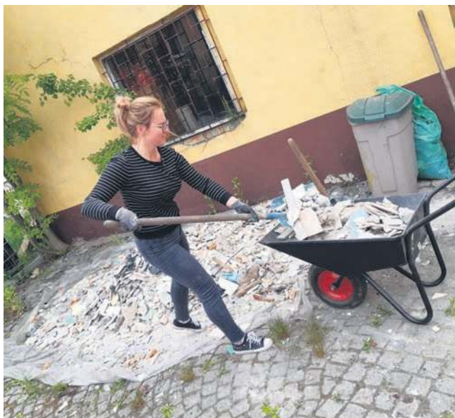
Nawet panie pracowały przy remoncie remizy w Chrzanowie. Na zdj. Kamila Cyran
