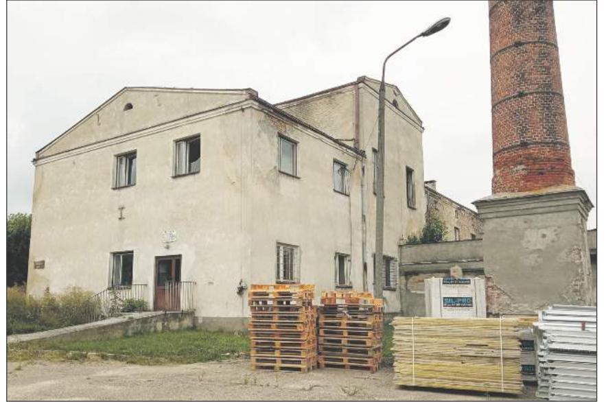
■ Budynek gorzelnii stał na placu PKS jeszcze do stycznia tego roku (fot. archiwum)
