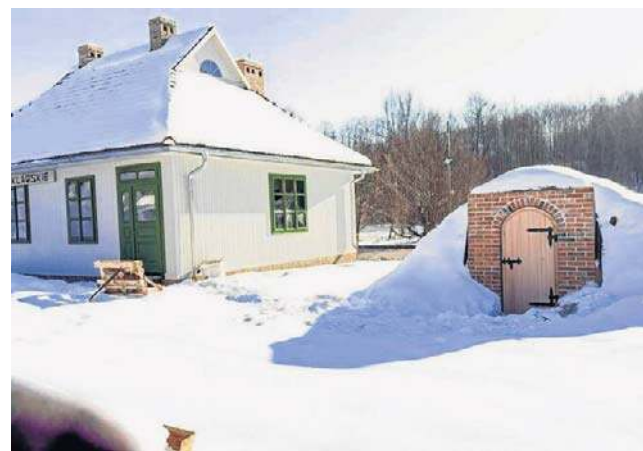
W odrestaurowanym budynku znajdują się kasy i poczekalnia oraz przestrzeń wystawowa
