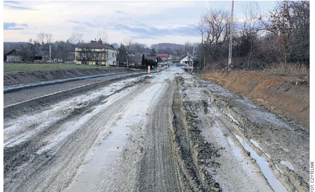
Jazda tą drogą samochodem grozi uszkodzeniem zawieszenia
