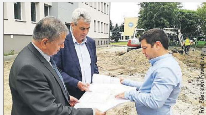
Trwa doglądanie budowy.
