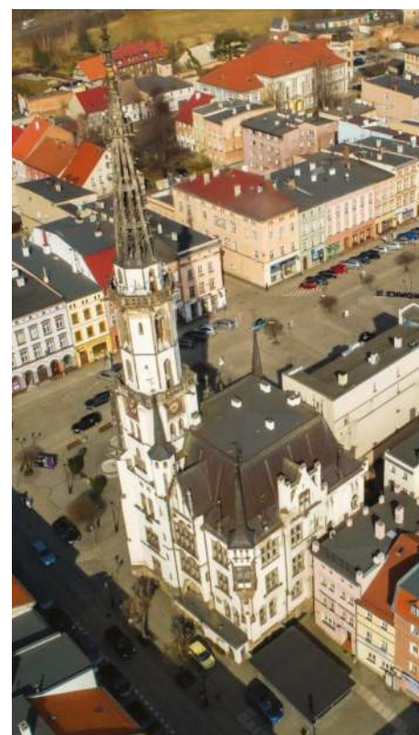
Rys. 1. Inwentaryzowany obiekt – budynek ratusza w Ząbkowicach Śląskich
