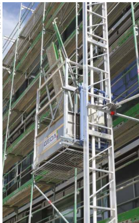
Fot. 3. Modułowy system kotwień dźwigu GEDA 200 Z Comfort
