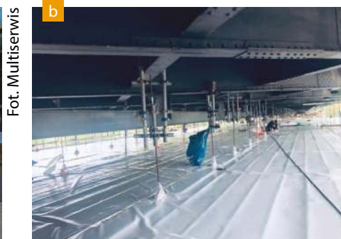
Fot. 2. Podwieszenie rusztowania modułowego na systemowych belkach aluminiowych Layher FlexBeam:
