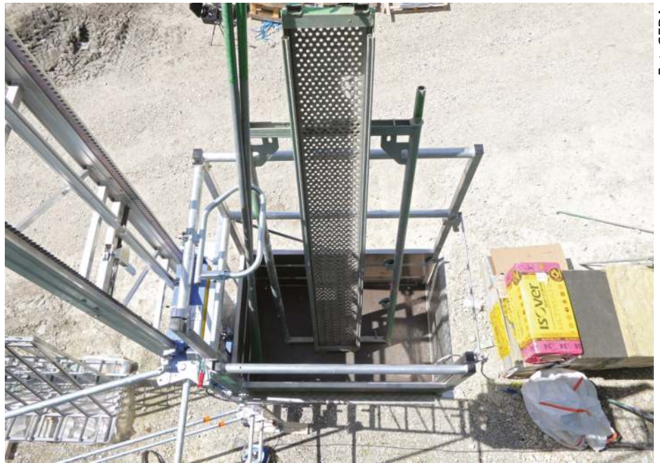
Fot. 8. Przesuwana do rozładunku platforma dźwigu GEDA 200 Z Comfort
