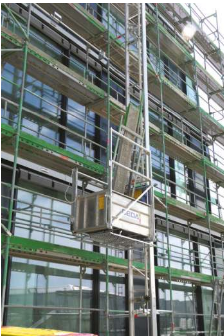
Fot. 1. GEDA 200 Z Comfort – nowy dźwig rusztowaniowy, przeznaczony do wykorzystania podczas montażu i demontażu rusztowań
