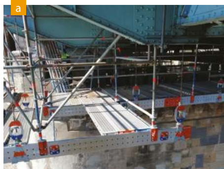
Fot. 2. Podwieszenie rusztowania modułowego na systemowych belkach aluminiowych Layher FlexBeam:
