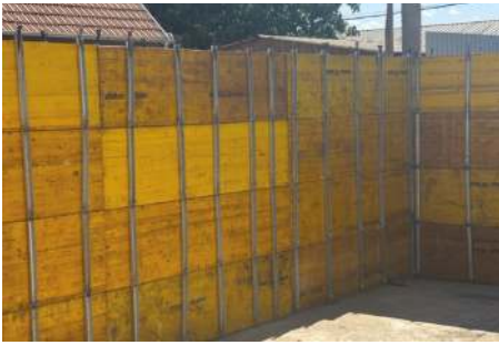
Rys. 4. Deskowanie ścian wykonane z płyt trójwarstwowych, ściąganych za pomocą stalowych pasków krępowanych klinami
