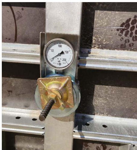
Rys. 9. Przyrząd zegarowy pozwalający określić w czasie rzeczywistym wartość siły rozciągającej w ściągu
