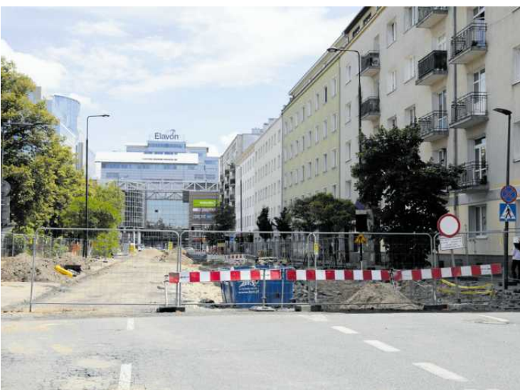
• Budowa linii tramwajowej na ul. Rakowieckiej
