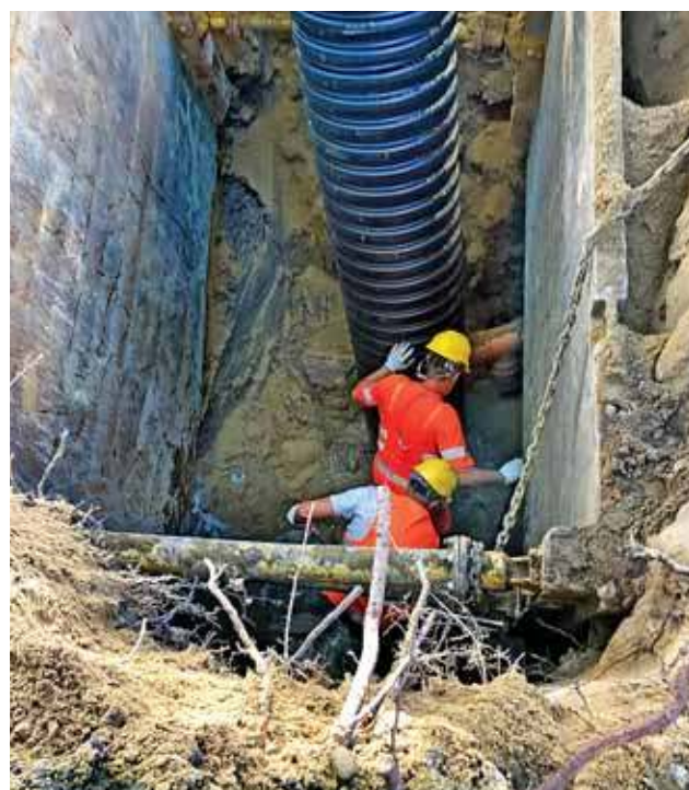
Budowa sieci kanalizacji sanitarnej
