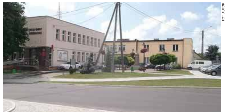
Rzut oka na dzierzgowski rynek. Budynki zajmowane przez administrację gminną też ostatnio zostały zmodernizowane
