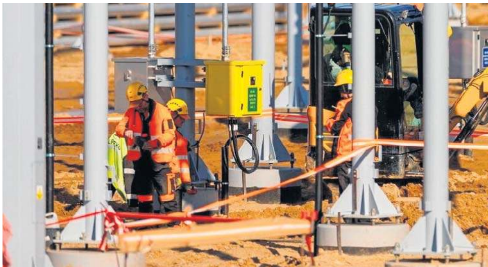
Stacja elektroenergetyczna Choczewo na ostatnim etapie budowy
