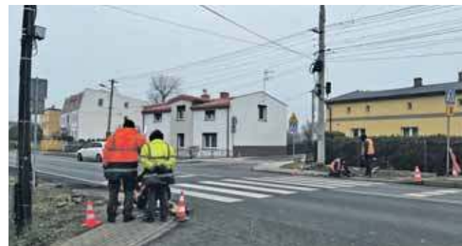
Trwają prace przy oświetleniu przejścia dla pieszych w Bobrownikach Śl.
