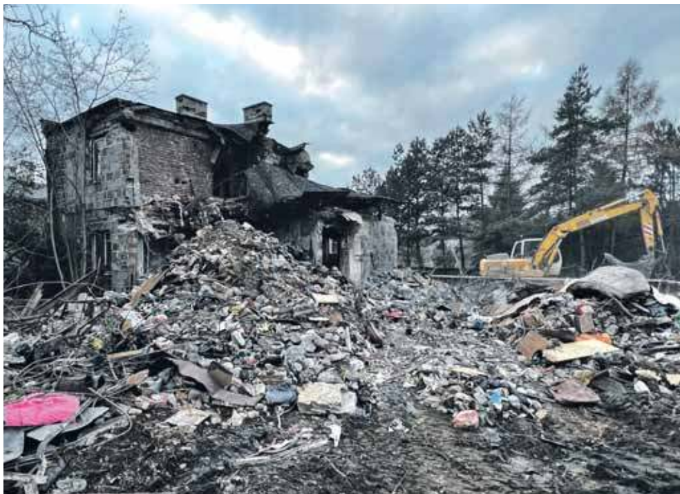
Trwa rozbiórka budynku przy ul. B. Śmiałego
