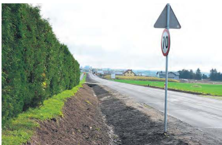
Prace między Tucholą a Bładowem posuwają się w szybkim tempie. Realizowany jest ostatni etap odtwarzania rowów.
