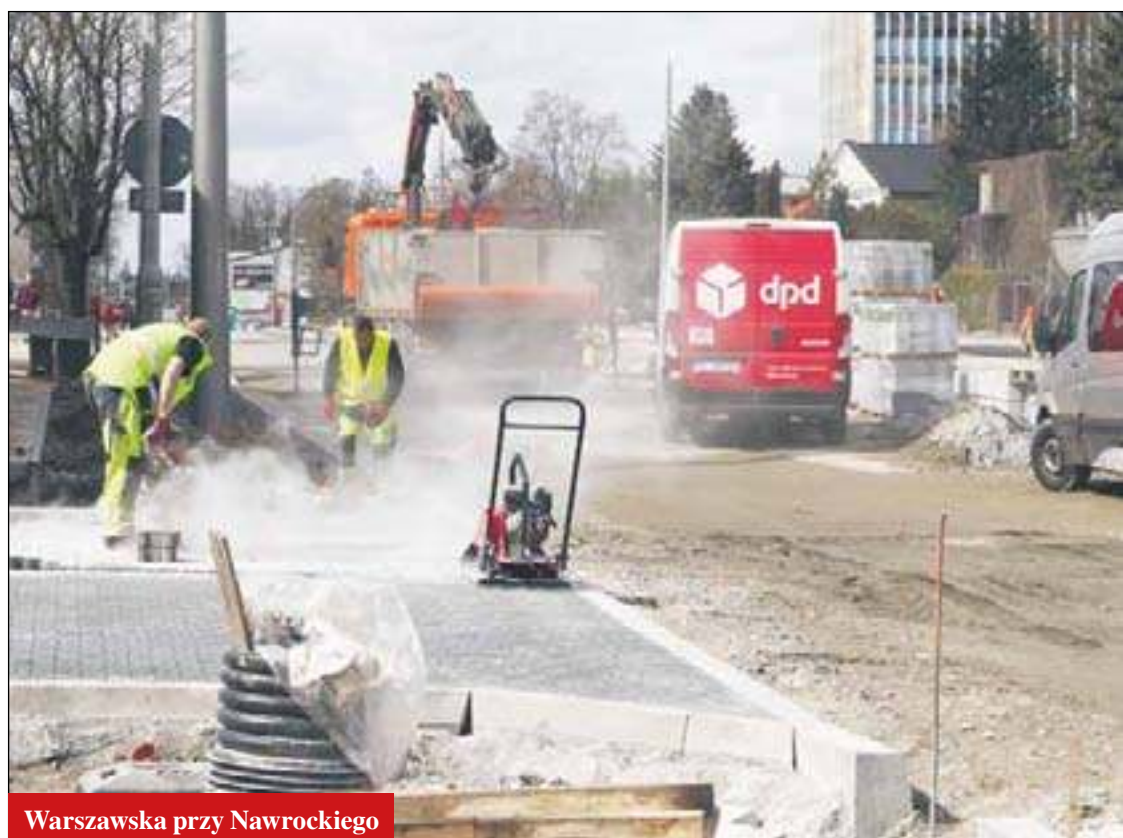
Remont mostu na Dobrzyńce
