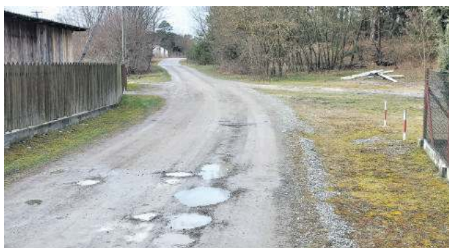
Obecna droga gruntowa zostanie zmodernizowana i pokryta asfaltem
