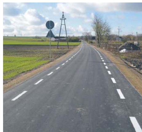
Przebudowa 23 odcinków dróg o długości ponad 21 km
