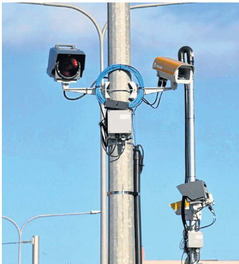
System RedLight na drodze krajowej nr 22 w Malborku
