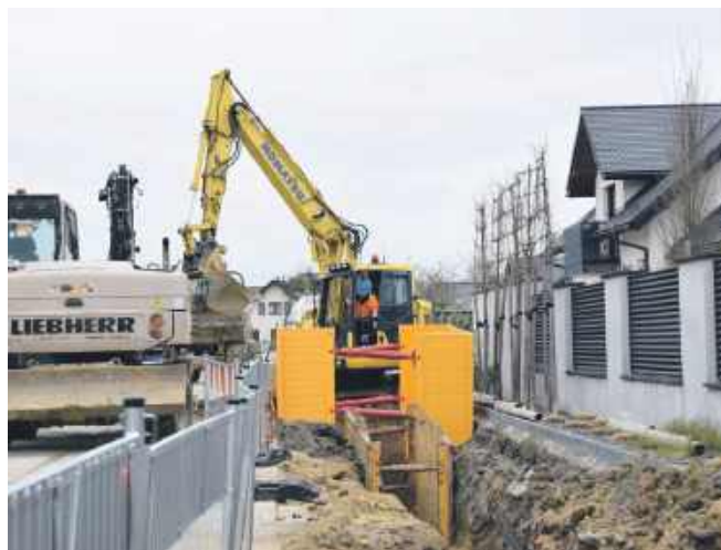
Trwa budowa kanalizacji sanitarnej w Krzyżanowicach
