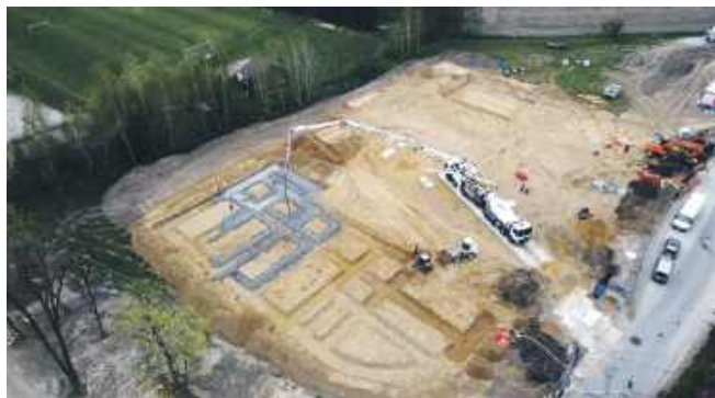
Ruszyły prace nad fundamentami nowej szkoły
