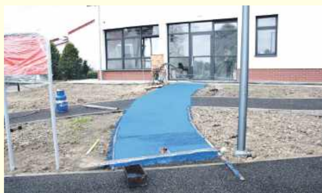
Nowa nawierzchnia pod urządzenia na placu zabaw
