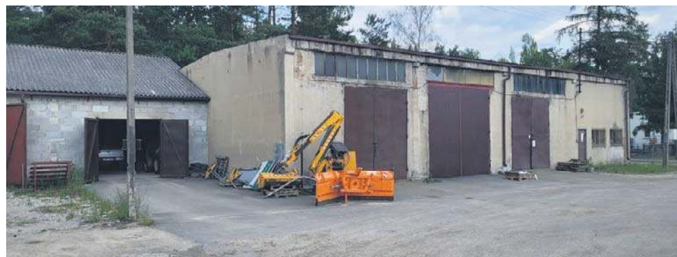
Budynki zaplecza Powiatowego Zarządu Dróg Publicznych w Białobrzegach będą wyremontowane, zakres prac jest bardzo duży.
