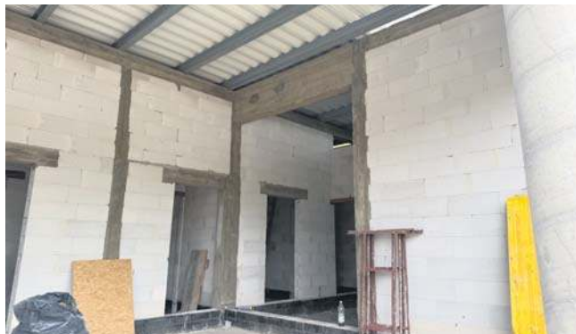
Wewnątrz budynku dworcowego są już wymurowane ścianki działowe.
