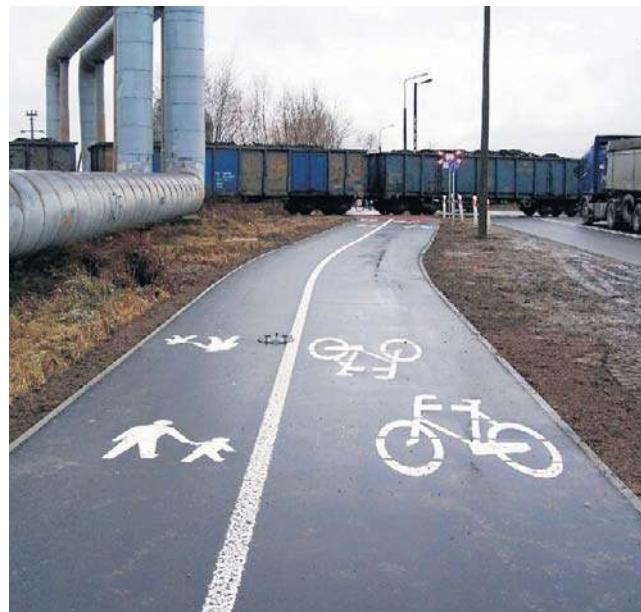
Kolejny odcinek ścieżki rowerowej zostanie zbudowany na ulicy Energetyków w Radomiu.
