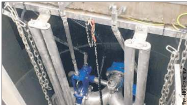
Gmina Przecław wzbogaciła się o kanalizację sanitarną i przepompownię obsługującą kilka wsi.
