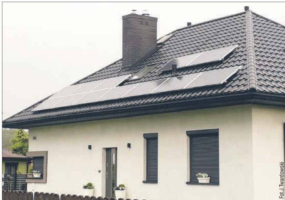
Zainstalowanie paneli fotowoltaicznych na dachu własnego domu zwróci się nam po około 6-7 latach. Potem będziemy mieć własny, całkowicie darmowy prąd.
