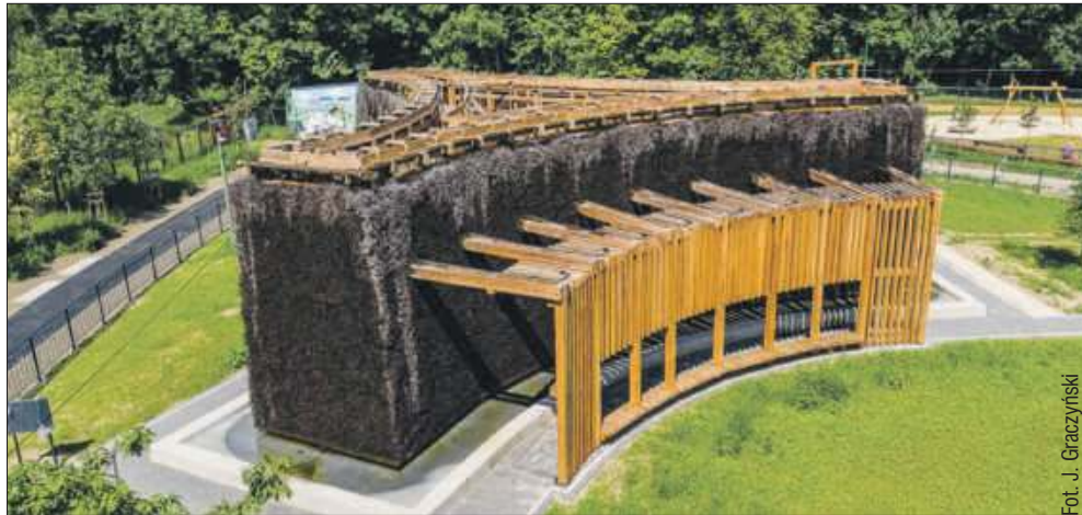
Jedną z ciekawszych inwestycji będzie budowa tężni solankowej na os. Lotników w Mielcu.
