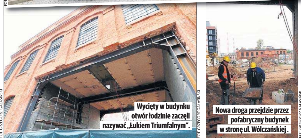
Budynek dawnej suszarni fabryki Geyera z wyciętym otworem na nową ulicę.
