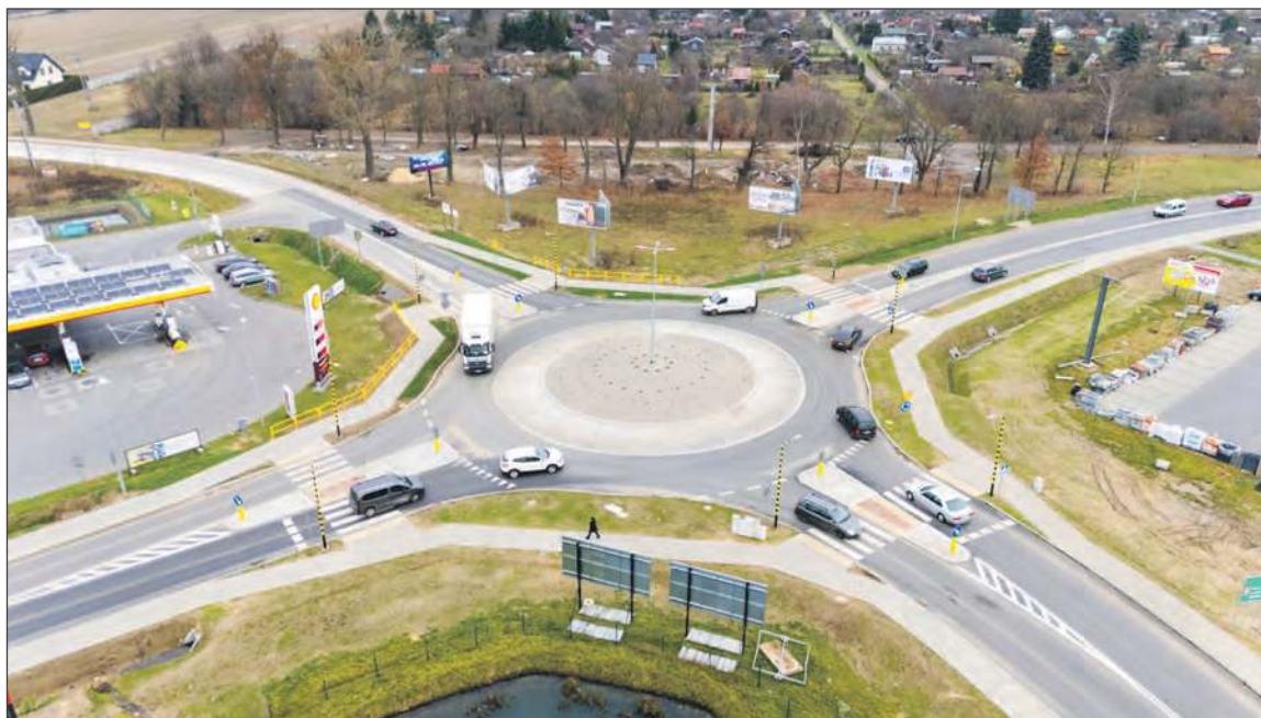
✚ Budowa ronda w rejonie Garwolińskiej Strefy Aktywności Gospodarczej, przy zjeździe z drogi ekspresowej S17, była jedną z ważniejszych i długo wyczekiwanych inwestycji drogowych w Garwolinie
