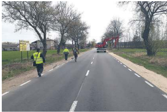
Na drodze powiatowej trwają ostatnie prace porządkowe
