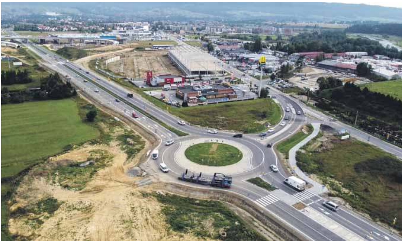
Nowe rondo umożliwi bezkolizyjny wjazd z ul. Szaflarskiej na zakopiankę.
