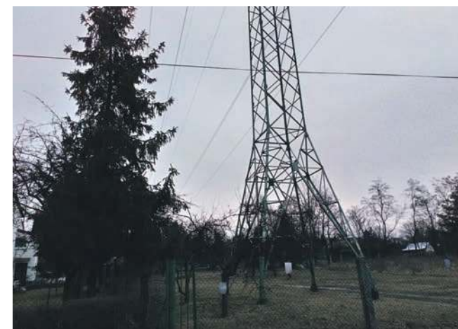
Tauron Dystrybucja SA planuje wymianę słupów wysokiego napięcia
