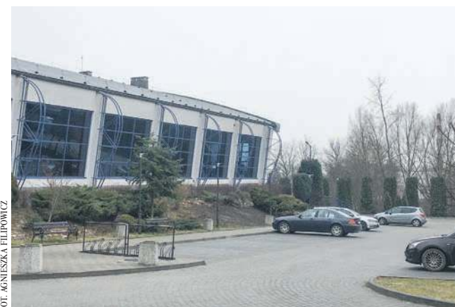
Prace nad przyłączeniem basenu do miejskiej sieci wodociągowej dobiegły końca. Parking jest już w całości dostępny dla klientów.
