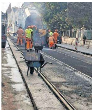
Remont ulicy Grzegórzeckiej powoli zmierza do finału
