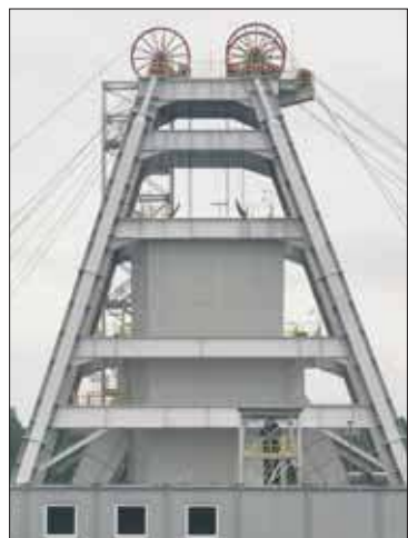
Kto dokończy budowę szybu?
