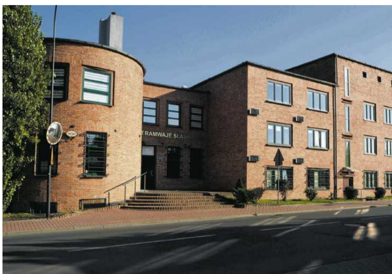
• Zajezdnia w Chorzowie FOT. TRAMWAJE ŚLĄSKIE
