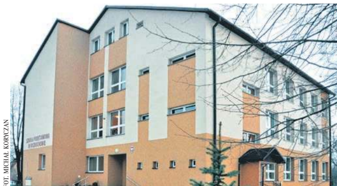
Budynek Szkoły Podstawowej w Rozkochowie
