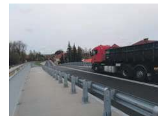
Z końcem zeszłego tygodnia pomalowano pasy na jezdni nowego wiaduktu
