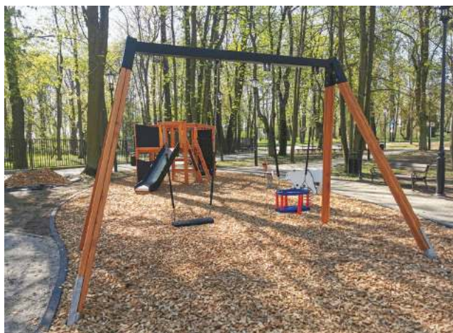
Drewniane zrębki jako nawierzchnia na nowym placu zabaw obok GKO.
