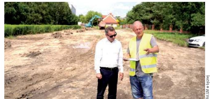
Burmistrz Łęcznej, Leszek Włodarski, kontrolujący rozpoczęcie prac werowa. Koszt prac to 5,275 mln złotych.
