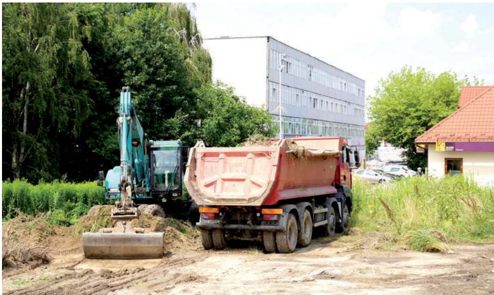
Rozpoczęto przygotowanie terenu pod budowę dwóch nowych dróg, które odkorkują wyjazd z centrum Łęcznej
