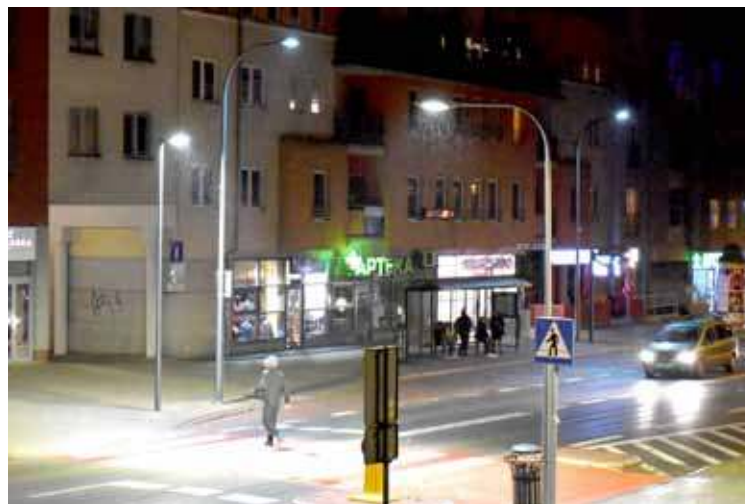
Przejście to zostało dodatkowo oświetlone przez co jest bezpieczniejsze
