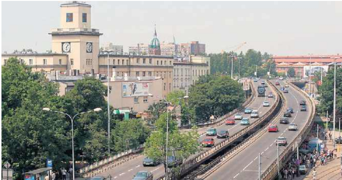
Estakada do czerwca ubiegłego roku była jednym z ważniejszych szlaków transportowych na terenie Górnośląsko-Zagłębiowskiej Metropolii
