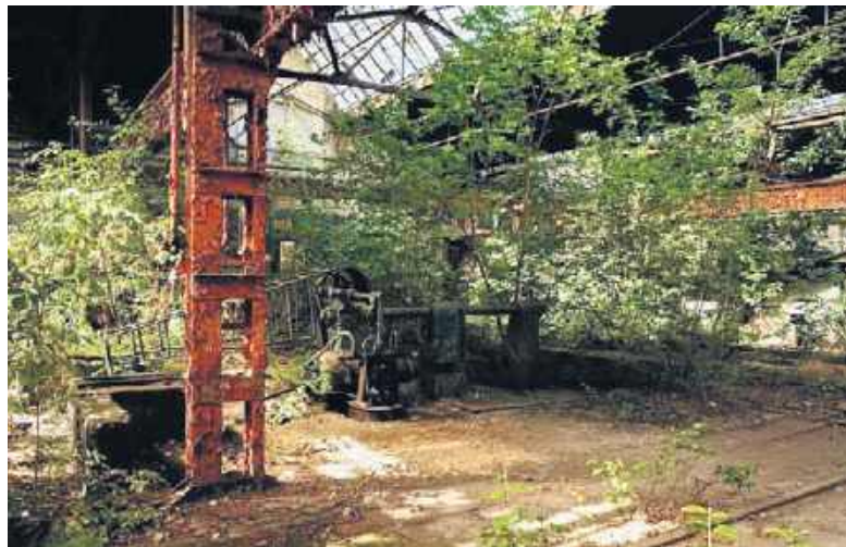
Dawne Warsztaty Naprawcze Górnolaskich Kolej Wąskotorowych w Bytomiu-Rozbarku dziś tworzą niecodzienną przestrzeń
