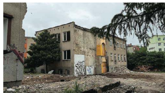
Widoczny efekt prac: wyburzenie łącznika między bryłami budynku wyraźnie otworzyło i doświetliło przestrzeń
