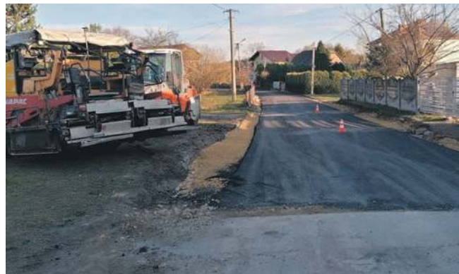
Trwa remont ul. Olszynka
