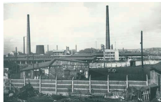
Widok na trzebińską rafinerię, lata 70.
