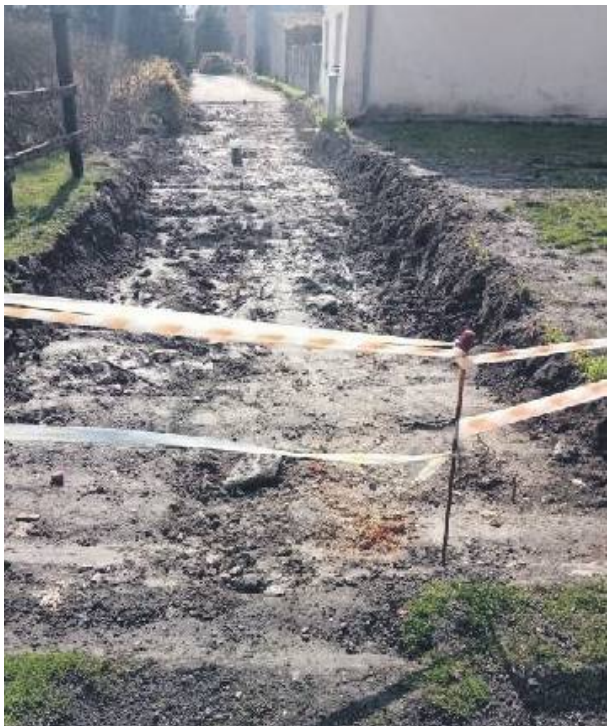
Wykop przy posesji mieszkańca w Kucharzowicach. Fot. Czytelnik
