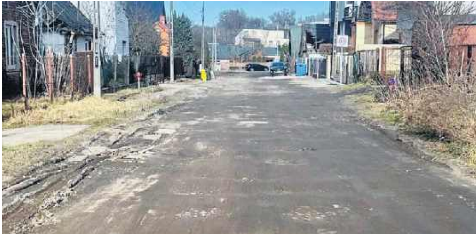
Ulica świętego Floriana w Radomiu będzie przebudowana, zostaną tutaj ułożone nowe asfalt i chodniki. Dziś to droga gruntowa z dziurami i błotem po każdym deszczu.
