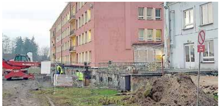
Prace przy przebudowie dawnej szpitalnej kuchni
