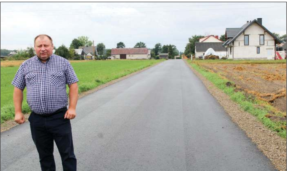
Nowy odcinek asfaltowej drogi w Kawęczynie kosztował 127 tys. zł. - Dzięki temu część mieszkańców ma lepszy dojazd do swoich domów, a rolnicy do pól - mówi radny z Kawęczyna Witold Łukasiak
