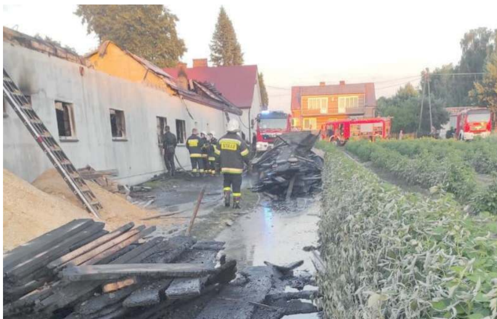
W Brzozowicy ogień rozprzestrzenił się bardzo szybko. Kiedy dojechały straże, prawie cały budynek był już objęty pożarem, ogień zajmował wiatę, garaż i stojący obok dom
