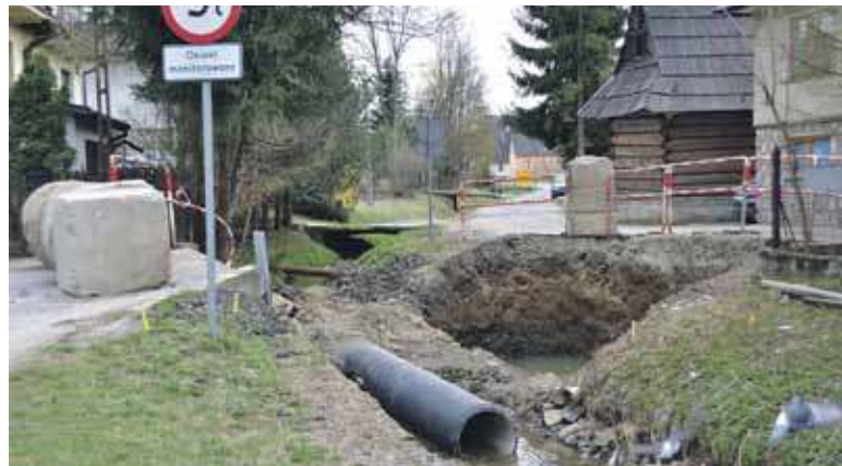
Stary most rozebrany, a w jego miejsce stanie nowa, betonowa konstrukcja.
